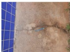
Foto 3 - Fissuras nas calçadas internas
