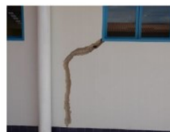
Foto 49 - Fissuras na parede externa
