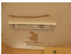
Foto 48 - Fissuras no teto
