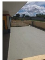
Foto 07: Reparos no piso de concreto despenhado do Solário
