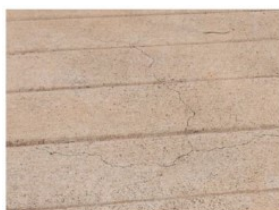
Foto 18 - Fissuras na rampa de acesso à CEPI
