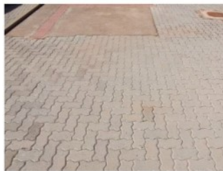
Foto 17 - Piso do palco com blocos intertravados no lugar do concreto desempenado
