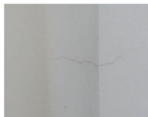
Foto 23 - Fissura na parede externa do Bloco da Administração
