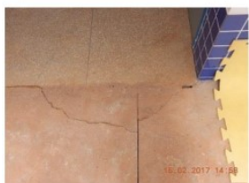
Foto 20 - Fissuras no solário do Bloco Pedagógico I
