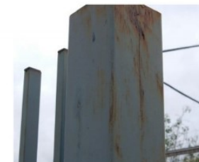
Foto 16 - Portão da área de serviços com corrosão
