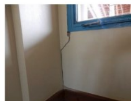
Foto 43 - Fissuras na parede
