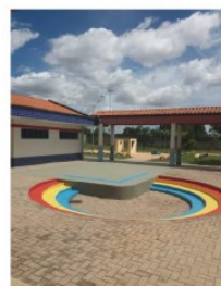
Foto 14: Reparos do piso do palco do Anfiteatro
