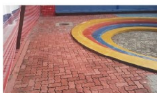
DEPOIS: Correção do Piso intertravado - Pátio Descoberto
