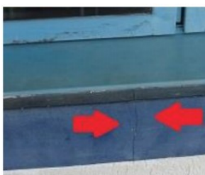
Foto 9 - Moldura da esquadria com fissuras
