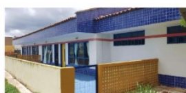
ANTES: Trincas nas fachadas e lajes externas.
