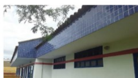
DEPOIS: Recuperação de trincas e pintura nas fachadas e lajes externas.
