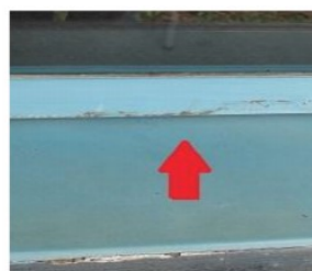
Foto 10 - Esquadria com corrosão
