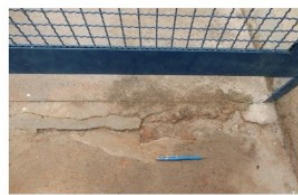
Foto 7 - Piso de concreto descamando
