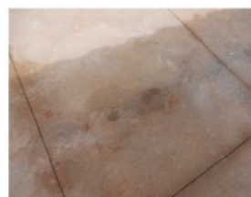
Foto 37 - Piso de concreto com acabamento ruim
