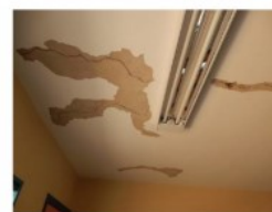
Foto 47 - Fissuras no teto do multiuso
