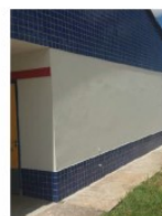
Foto 09: Reparos no piso de concreto despenhado da calçada
