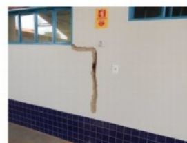
Foto 45 - Fissuras na parede externa
