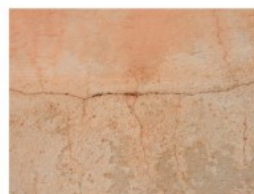
Foto 55 - Piso de concreto com fissuras
