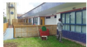
DEPOIS: Recuperação de trincas e pintura nas fachadas e lajes externas.
