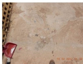
Foto 21 - Piso de concreto do solário da creche I descamando e com acabamento ruim
