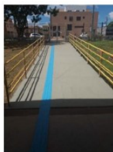
Foto 01: Recuperação do piso da calçada de acesso ao CEPI
