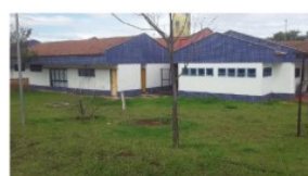
DEPOIS: Recuperação de trincas e pintura nas fachadas externas.
