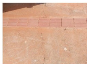
Foto 19 - Calçada externa com fissuras
