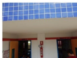
Foto 24 - Teto com desnivelamento
