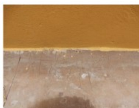
Foto 36 - Piso de concreto com fissuras
