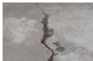
Foto 6 - Piso de concreto do solário com fissura
