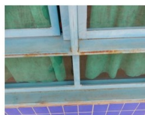
Foto 12 - Esquadria com corrosão
