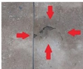
Foto 1 - Placas de concreto destacando
