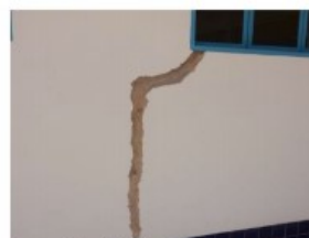
Foto 53 - Fissura na parede externa
