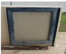
Foto 15 - Portão do solário com pintura desgastada
