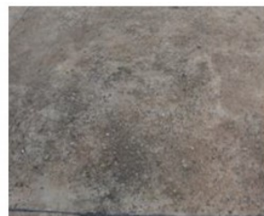
Foto 2 - Piso de concreto com desagregação
