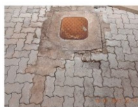
Foto 27 - Blocos de concreto mal encaixados
