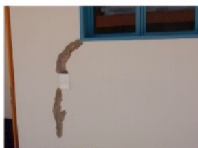
Foto 52 - Fissura na parede externa
