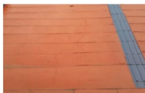
ANTES: Fissuras no piso da rampa
