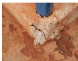
Foto 54 - Piso de concreto descamando
