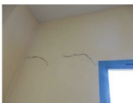
Foto 42 - Fissuras nas paredes
