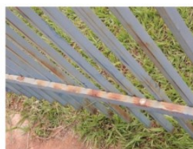
Foto 14 - Portão com corrosão
