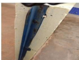
Foto 13 – Suporte do portão do solário com corrosão
