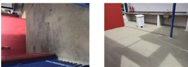
ANTES e DEPOIS: Detalhe do piso externo do varal do bloco de serviços
