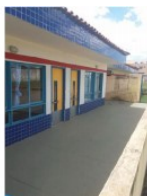
Foto 08: Reparos no piso de concreto despenhado do Solário
