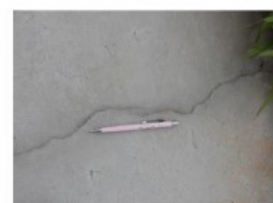
Foto 57 - Fissuras nas calçadas internas
