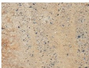
Foto 32 - Piso do palco do anfiteatro com desagregação
