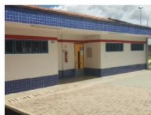
Foto 12: Reparos nos pisos localizados próximo ao anfiteatro
