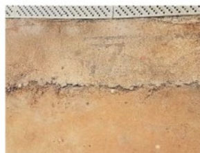
Foto 33 - Fissura no piso da área de serviços
