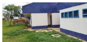
ANTES: Trincas nas fachadas externas.
