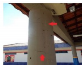
Foto 29 - Rachaduras nos pilares de concreto
