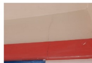
Foto 25 - Fissuras na parede se propagando desde a esquadria
