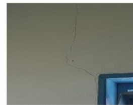
Foto 35 - Infiltrações no teto (vista pátio central)
