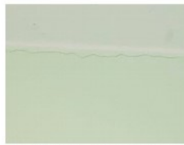
Foto 34 - Infiltrações no teto do hall de entrada
