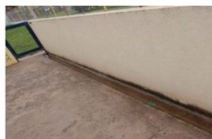
Foto 8 - Vala do piso de concreto sem caimento
