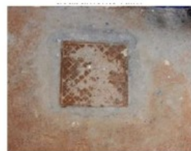
Foto 39 - Piso de concreto desempenado com acabamento ruim
