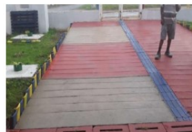
DEPOIS: Trechos com trincas no piso da rampa reparados.
