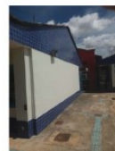
Foto 04: Reparos no piso de concreto despenhado da calçada e pintura da parede externa do Bloco Administrativo
