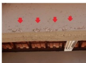
Foto 28 - Vigas de concreto com aspecto poroso
