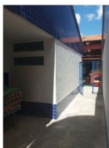
Foto 13: Recuperação da pintura da parede e do piso externo do Bloco Administrativo
