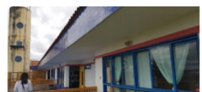
ANTES: Trincas nas fachadas e lajes externas.
