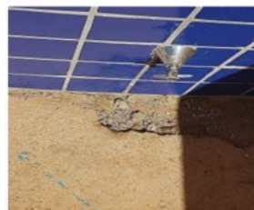
Foto 31 – Piso de concreto do solário do BP II com buraco
