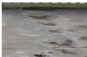
Foto 5 - Buracos no piso do solário
