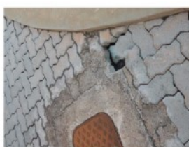
Foto 26 - Buracos no piso do entorno do anfiteatro
