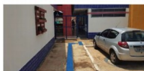
ANTES: Trincas nas paredes de Fachadas.
