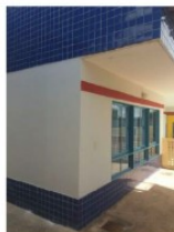
Foto 06: Reparo no piso de concreto despenhado próximo ao Castelo D'água
