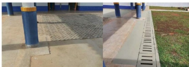
ANTES e DEPOIS: Detalhe do piso entre os pilares da passarela
