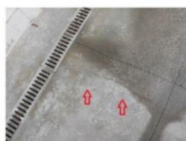
Foto 56 - Piso de concreto da área de serviço com fissura
