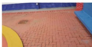
ANTES: Piso intertravado com defeito - Pátio Descoberto
