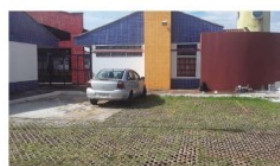
DEPOIS: Recuperação das trincas e pintura nas paredes de Fachadas.
