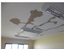
Foto 44 - Fissuras no teto da sala multiuso
