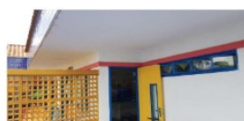
ANTES: Trincas e infiltrações nas lajes externas.
