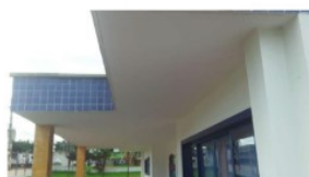
DEPOIS: Recuperação das trincas e pintura no teto da fachada frontal.
