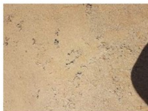
Foto 30 - Calçada de acesso à entrada da CEPI com desagregação
