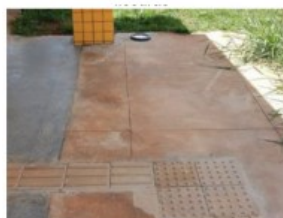
Foto 38 - Piso de concreto do hall de entrada com acabamento ruim
